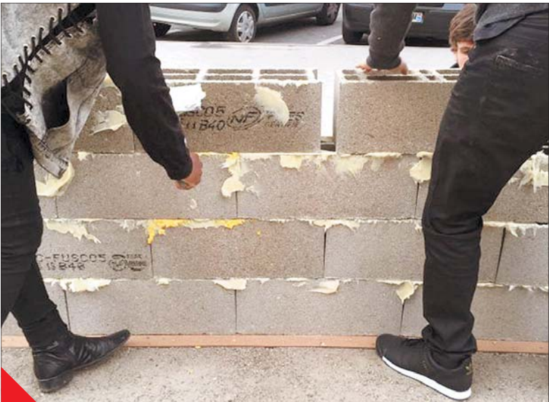
اجرای نمایشگاه فیاک پاریس
