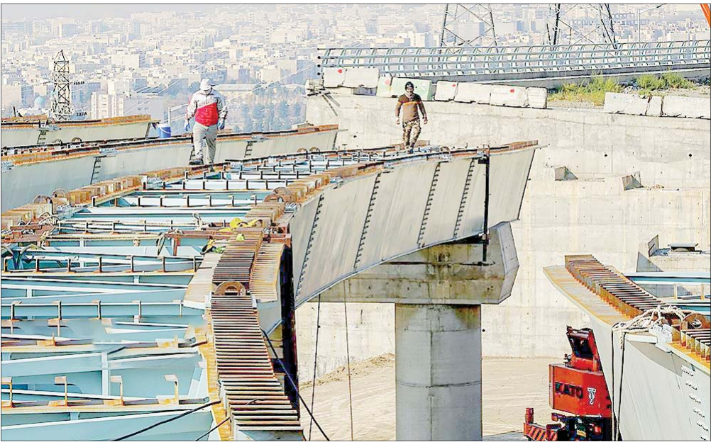
پروژه آزادراه شمالی کرج در صدر پروژه‌های پیشران ساخت آزادراهی کشور به جهت سرعت اجرا قرار گرفته است. آزادراه کنارگذر شمالی کرج به طول حدود ۱۹ کیلومتر بوده که از انتهای غربی آزادراه شهید کرج‌آغاز و با عبور از شمال شهر کرج و از محدوده شهرستان کمال‌شهر به آزادراه کرج-قزوین متصل می‌شود. عکس: میلا فیروزان، باشگاه خبرنگاران جوان
