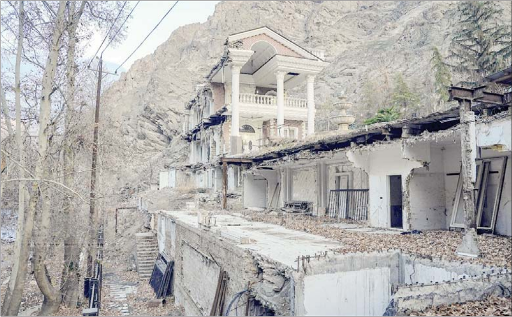
در روزهای گذشته گزارشی مبنی بر تخریب کامل قسمت غیرمجاز یک ابرویلا که در حاشیه رود کرچ بنا شده بود، با دستور قضائی پخش شد. دستور تخریب این ابرویلا در اسفند ۱۴۰۰ داده شد که به دلیل نوع سازه و همچنین هزینه بالای تخریب آن، اجرای عملیات تخریب زمان‌بر شد. عکس: مصطفی رودکی، میزان
