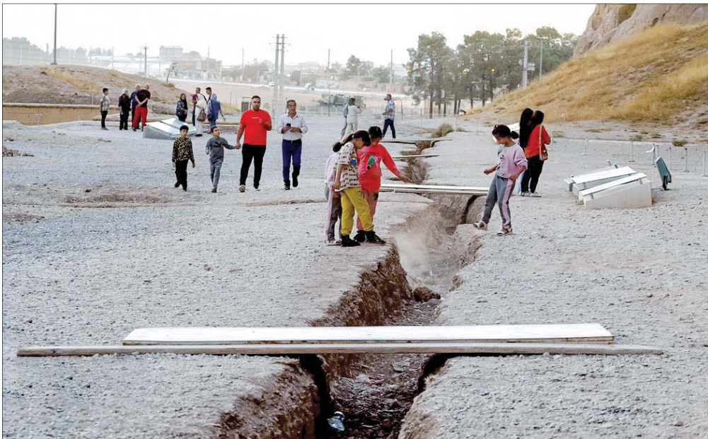
برداشت بی‌رویه آب از جاهای اطراف بناهای تاریخی نقش رستم، چند سالی است منجر به فرونشست زمین و ایجاد شکاف‌های بزرگی در اطراف این بناها شده و چالش‌های بسیاری را ایجاد کرده است. عکس: احمدرضا مداخل، فارس
