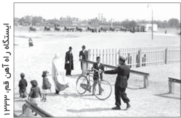
ایستگاه راه آهن قم، ۱۳۳۳
