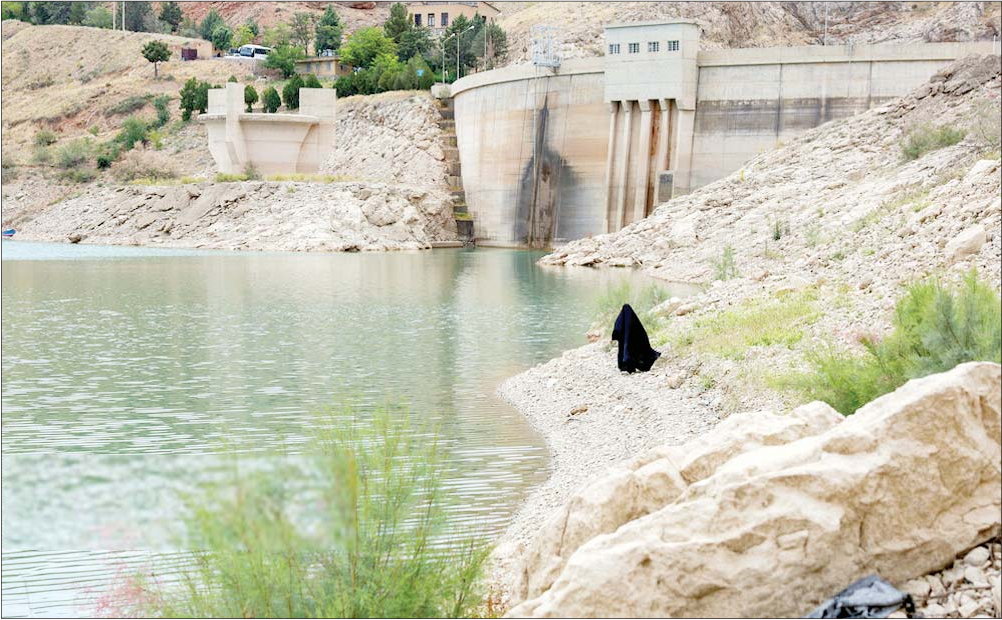
سد تونی دو قوسی کارده با ارتفاع ۷۰متر و طول تاج ۱۴۴متر بر روی رود کارده احداث شده است. این سد که در ۴۰کیلومتری مشهد قرار دارد یکی از سدهای تأمین کننده آب مشهد است. حجم کلی سد کارده در تراز نرمال ۲۰میلیون مترمکعب است اما در حال حاضر کمتر از ۱۰ درصد مخزن این سد آب دارد. معمولاً هر سال حدود ۵ تا ۶میلیون متر مکعب ورودی مخزن دارد اما در سال جاری یکی از سال‌های خشک مخزن است. عکس: سید محمد آل‌رسول، ایستا
