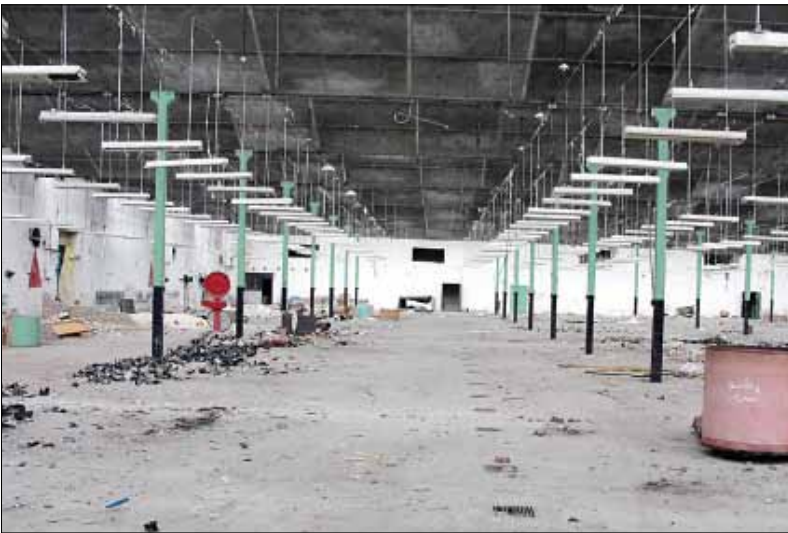
تخریب کارخانه‌های نساجی که تخریب شده است
