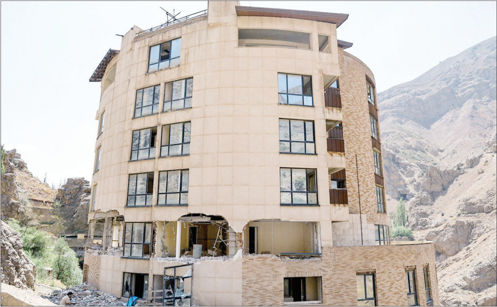
عملیات اجرای حکم قطعی دادگاه برای قلع‌وقمع و اعاده به وضع سابق یک ساختمان ۱۰طبقه و ۳۰ واحدی غیرمجاز در پلاک ۲۰ منطقه میگون شمیرانات آغاز شد. بنایی که در عرصه‌ای به مساحت حدود سه‌هزارو ۶۵۰ مترمربع از اراضی ملی احداث شده و ارزش آن بیش از دو هزار میلیارد تومان برآورد شده است. عکس: مهرداد اصفهانی، میزان
