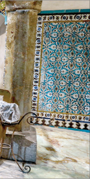
حمام تاریخی کنجعلی خان کرمان، یکی از شاخص‌ترین بناهای دوره صفوی. با آسیب‌های جدی در تزیینات کاشی‌کاری خود روبه‌رو شده است. بخش‌هایی از کاشی‌ها به‌قدری فرسوده شده‌اند که با کوچک‌ترین تماس فرو می‌ریزند و در برخی نقاط دیوار گرمینه نیز تورم و جادشدگی کاشی‌ها، خطر ریزش آنها را افزایش داده است. عکس: رحیم بنی‌اسدزاد، ایرنا
