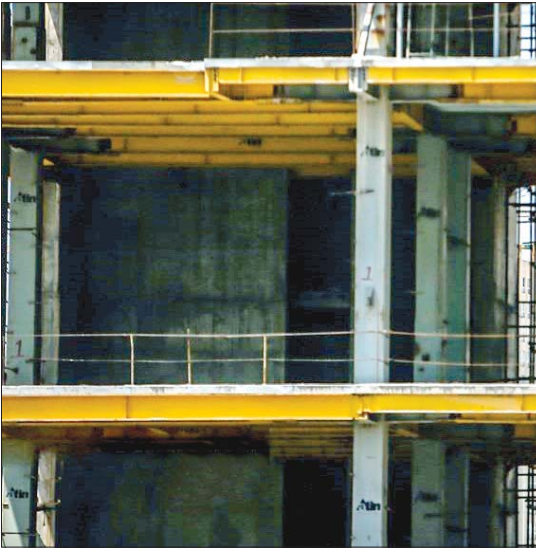
تکمیل عملیات ساخت آتا
