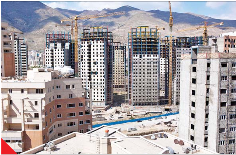
منظره‌ای از برج‌های ساخته شده در ضلع شمالی دریاچه
