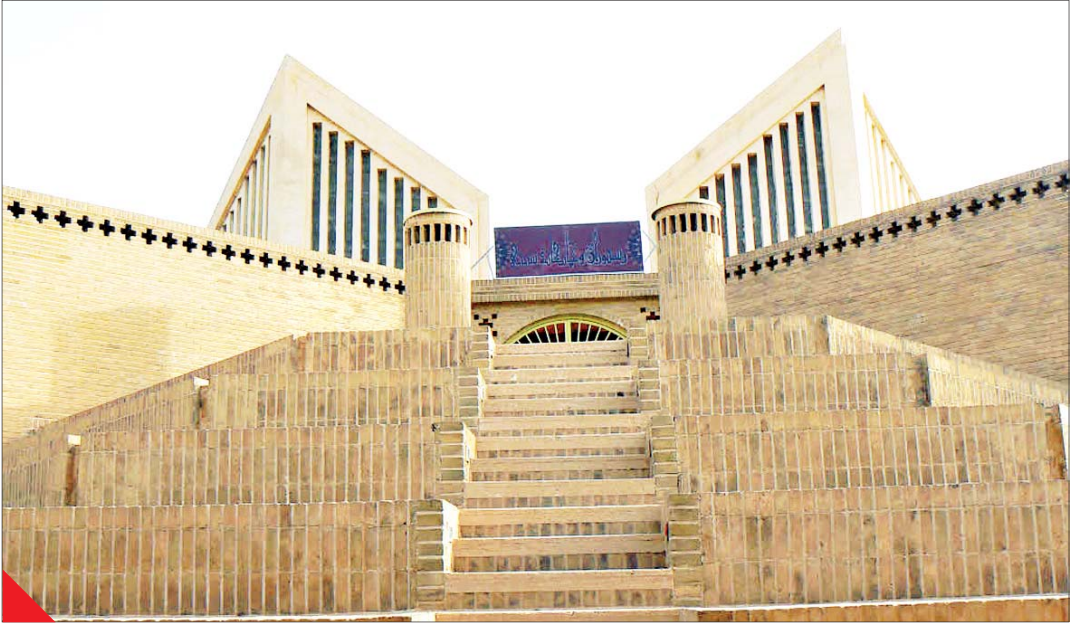
نمای بیرونی فرهنگسرای دزفول
