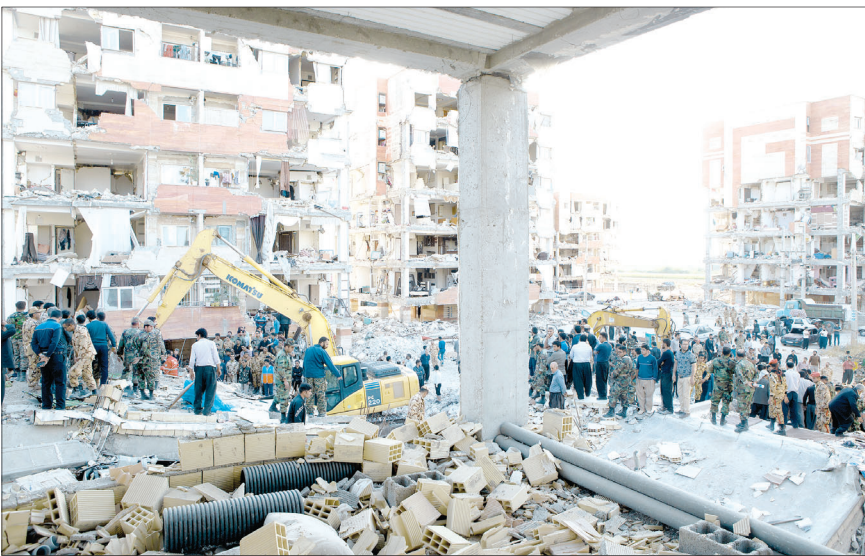
یک ساختمان در حال تخریب
