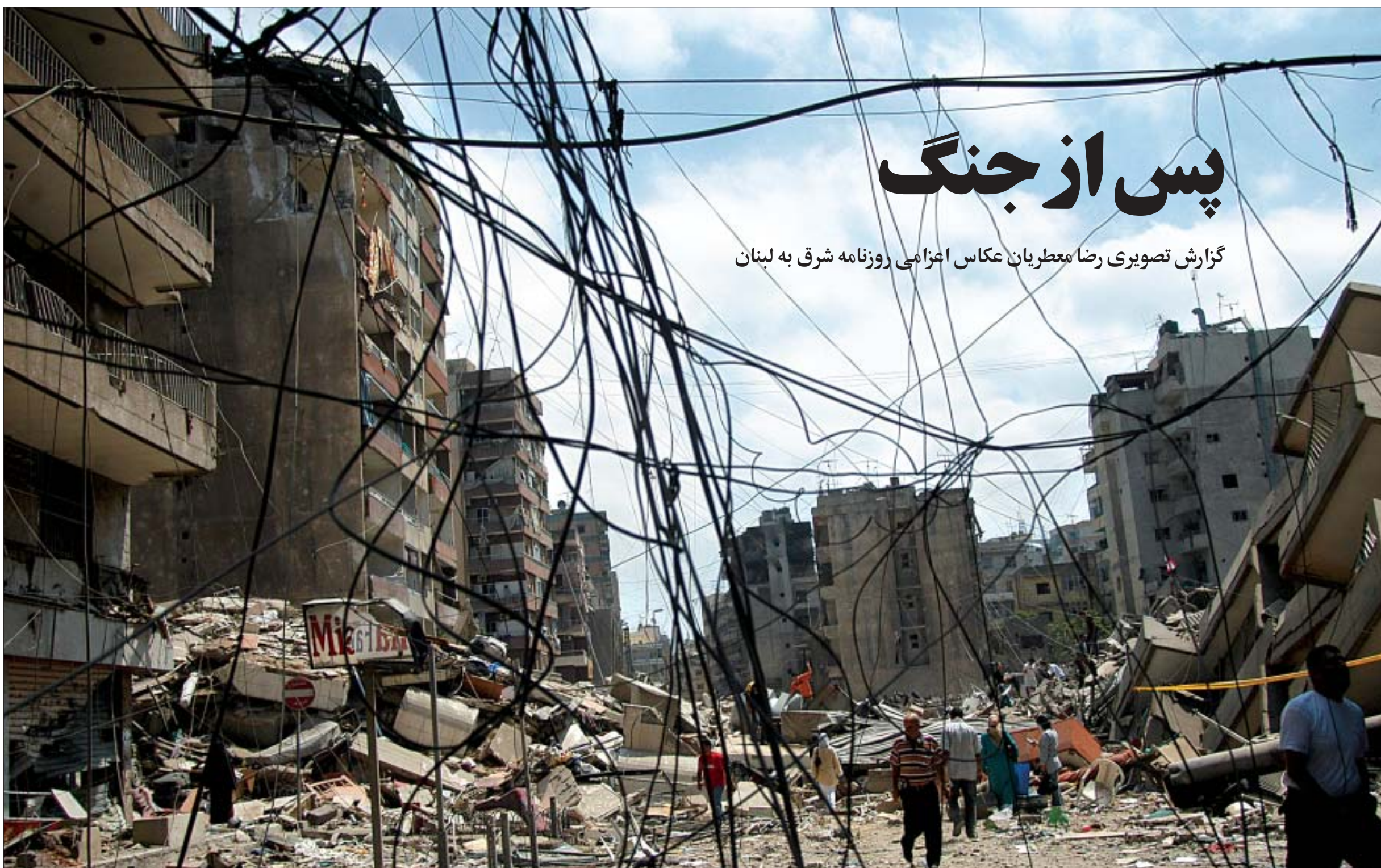
خرابیه‌های ناشی از جنگ در منطقه ضاحیه، بیروت
