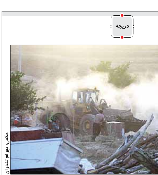
تلاش برای بازسازی مناطق زلزله‌زده در استان زنجان.
