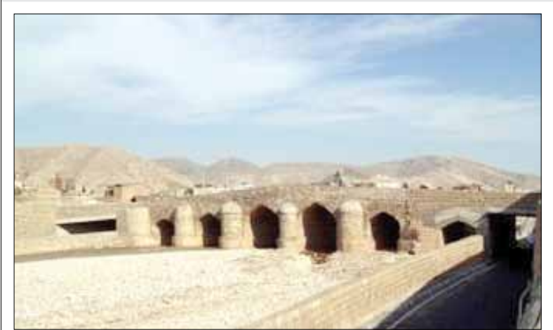
پل رودخانه خشک شیراز
