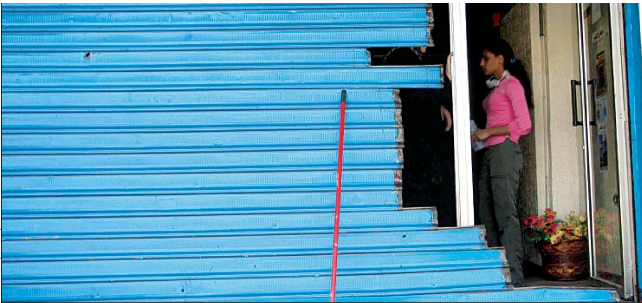
• در کف خیابان، عمارت مسکونی آسیب دیده در منطقه شرقی بیروت
