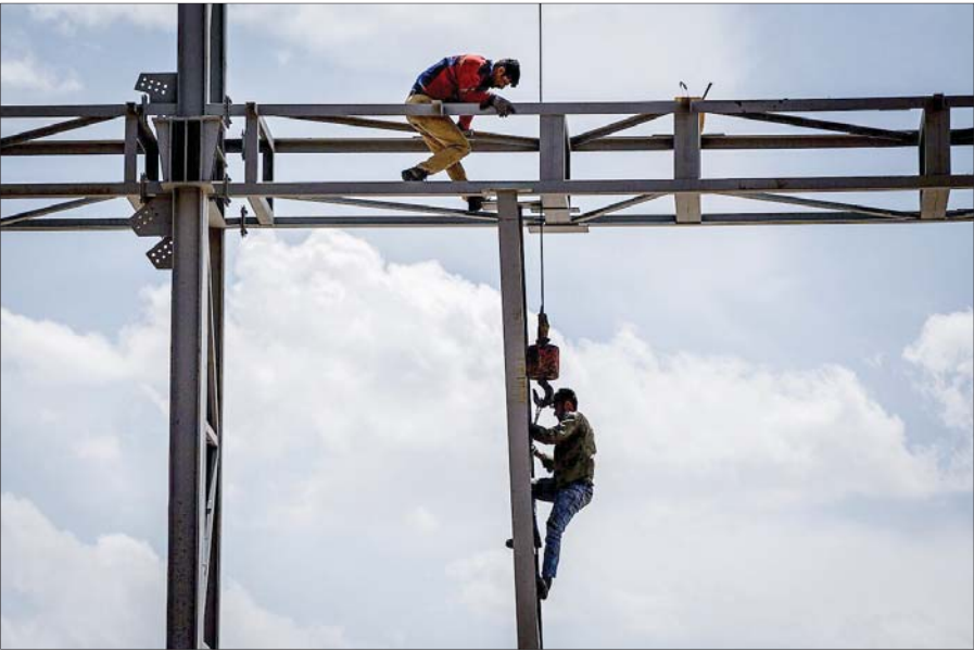
کارگران در حال ساختن پل
